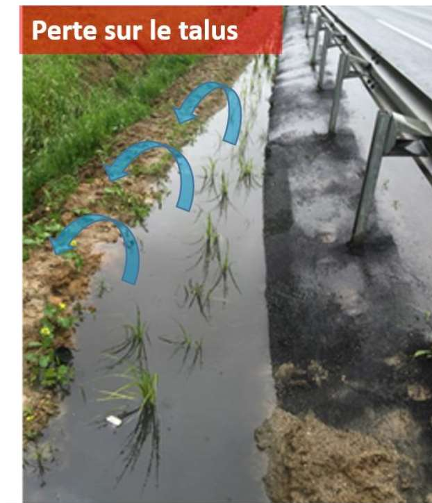
Figure 17 Photo de la noue filtrante montrant une possibilité de perte d'eau sur le talus (pris de Kanso, 2018)
